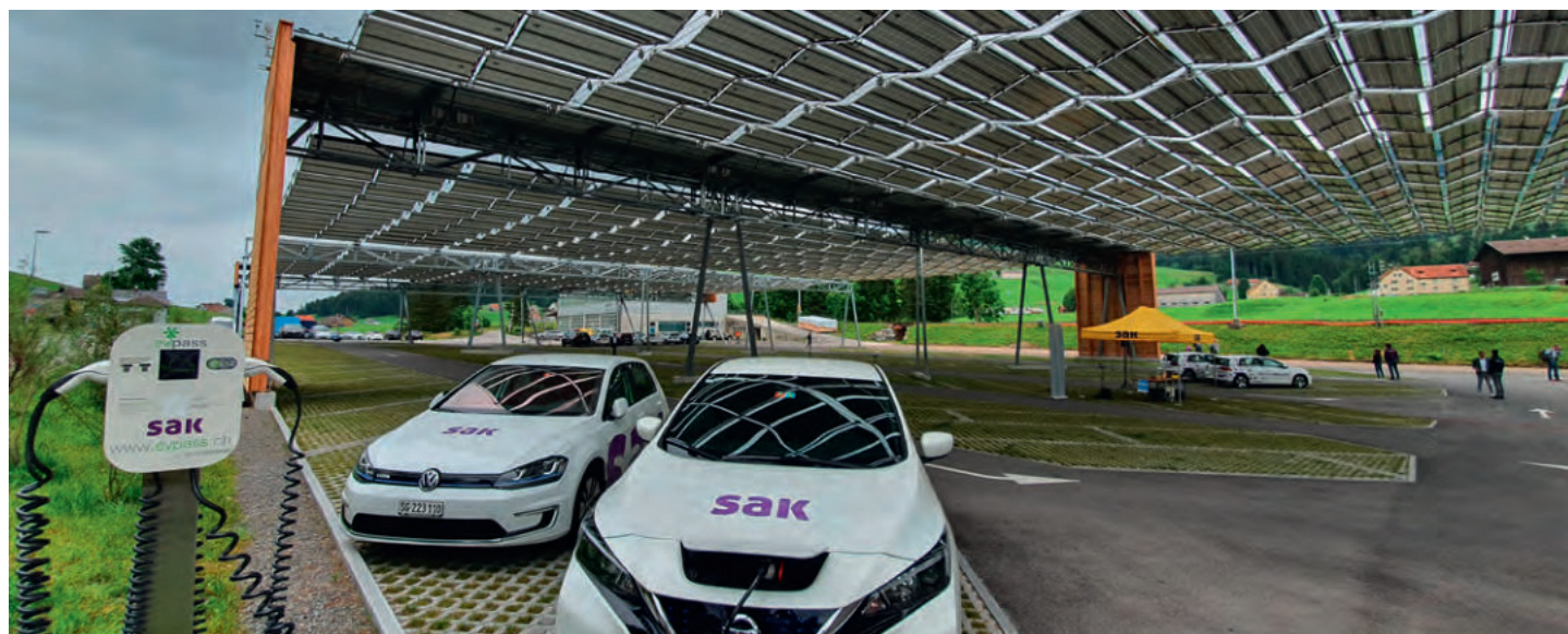
Bei Schlechtwetter wird das Solarfaltdach in die Garage zurückgefaltet.
